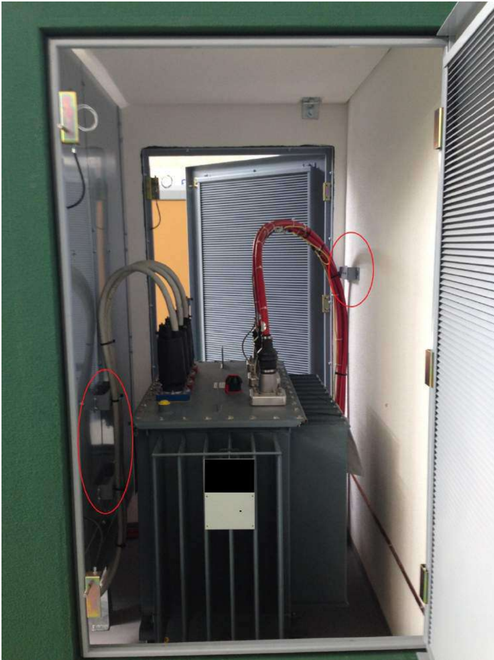
Figura 41 - posizione supporti cavo a parete
